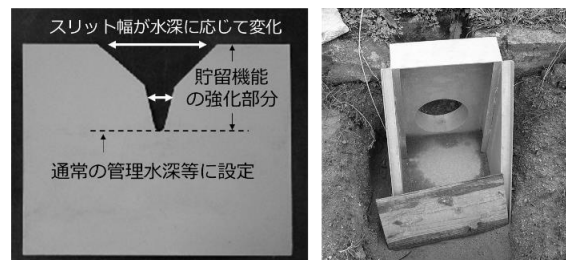
(a) 水田の水位調整板と軽量の落水柵
